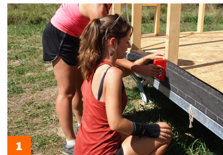
1 Future fixation du pare-pluie sur l'ossature...
