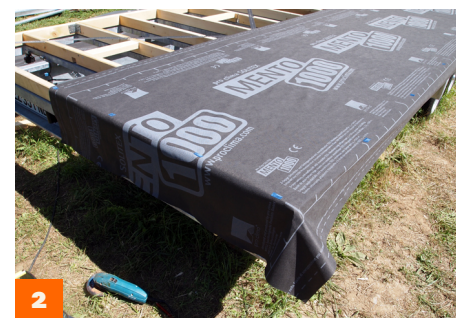
1 Future fixation du pare-pluie sur l'ossature...
