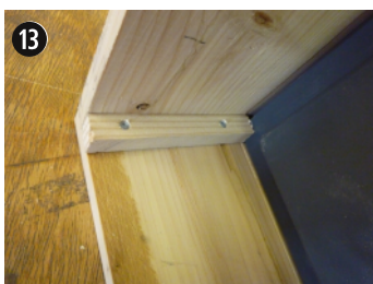
Tasseau renforcement dessous du bac 3.
