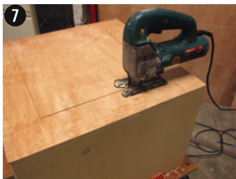
Ouverture de la caisse à la scie sauteuse avec une marge de 1 cm
