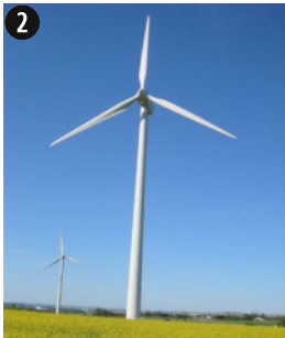
Éolienne à axe horizontal
