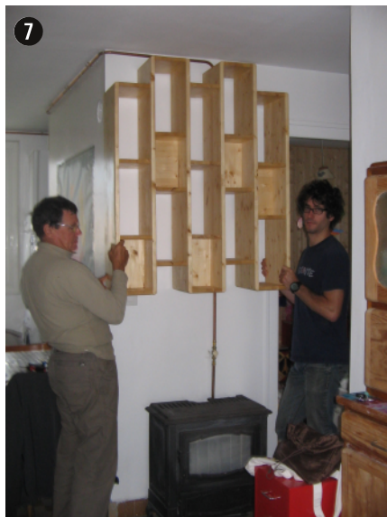
Repérage de l'emplacement de la découpe du passage du tuyau
