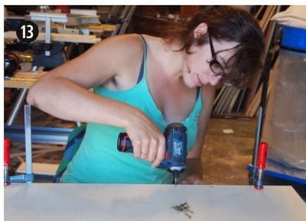
Collage et vissage des tasseaux C9 et C10 sur le fond C5
