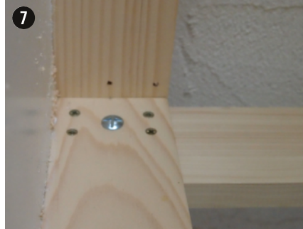
Fixation renforcée par des boulons pour les étagères du haut
